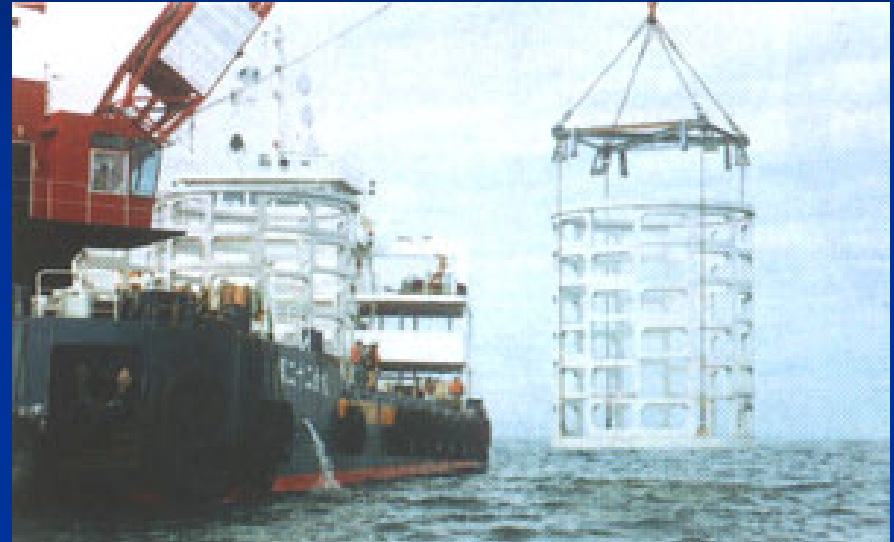
construction of artificial reefs ( http://www.foodkingdom-miyagi.jp/m/toukei/miyagi-suisan/suisan_5-3.htm )
